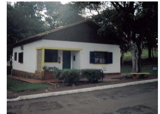
Figura 25: casa do bloco A. Fonte: Vianna, 2003.
