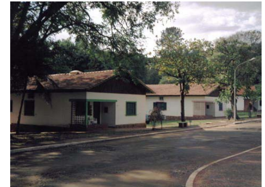
Figura 24: rua com casas do bloco A. Fonte: Vianna, 2003.
