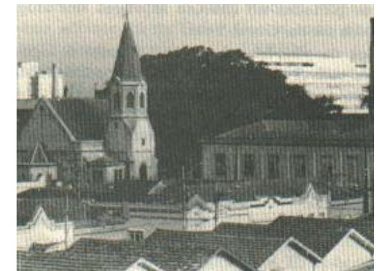
Figura 11: vista da vila M. Zélia. Fonte: Blay, 1985.
