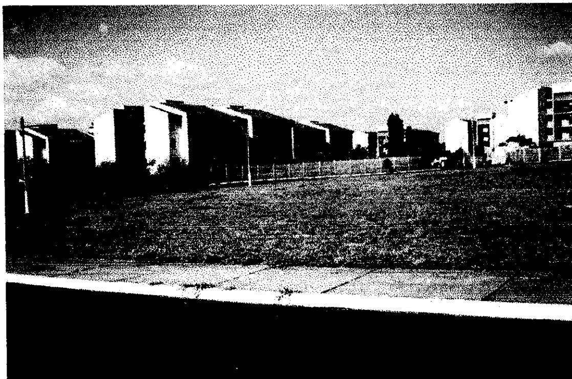
Vista praça e muros – CDHU
