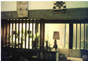
Caixilhos executados no local, com caibros de madeira e vidro.
