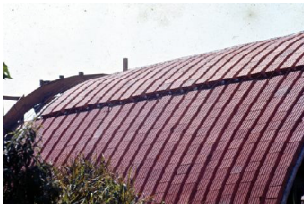
Construção da abóbada, Residência Dino Zamattaro
