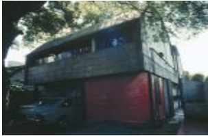
Fachada da frente, com o volume vermelho, da dependência das empregadas, a ser suprimido oportunamente.
