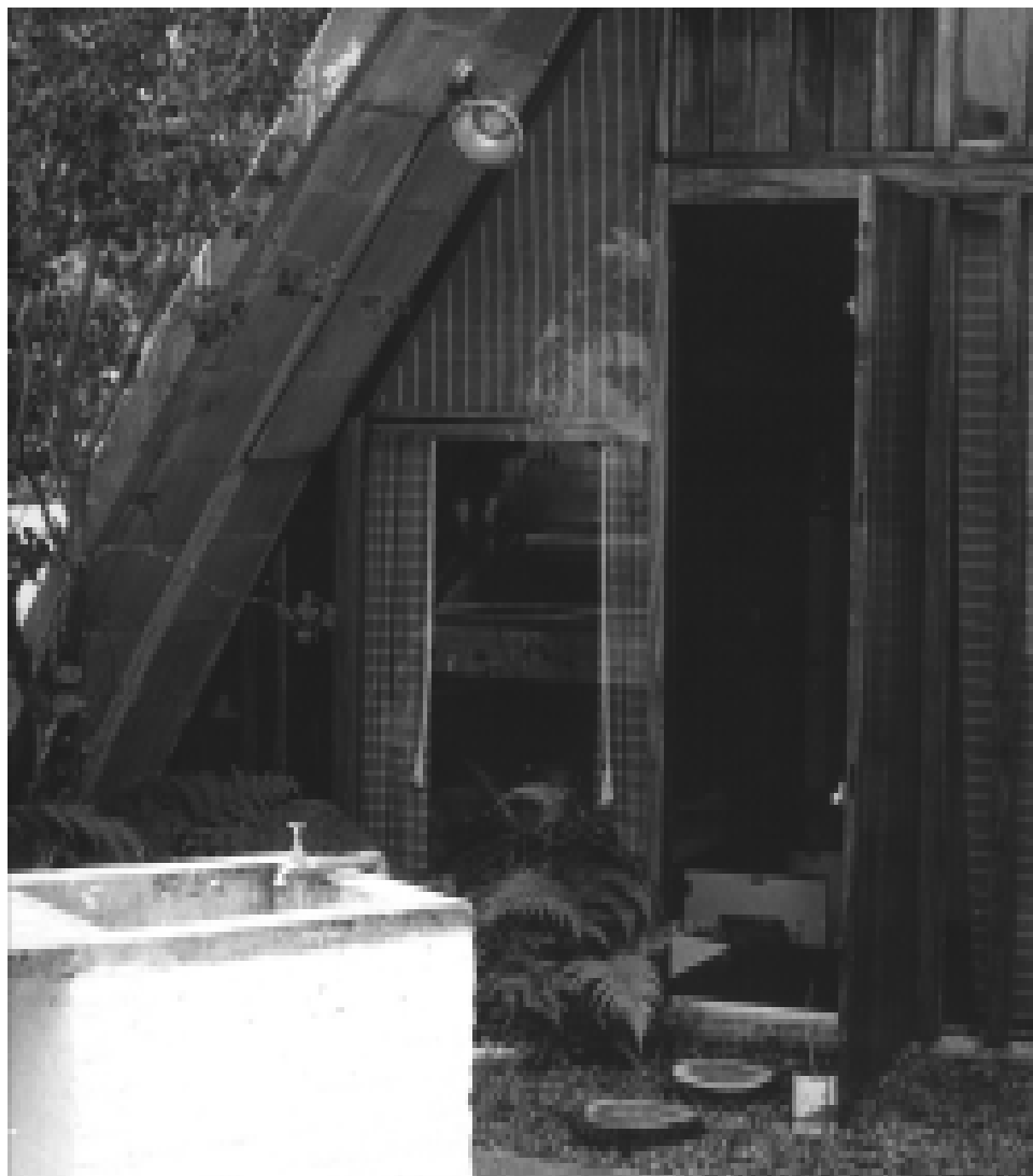
Caixilho de caibros de madeira e vidro, nos fechamentos de extremidade das abóbadas, executadas no local.
