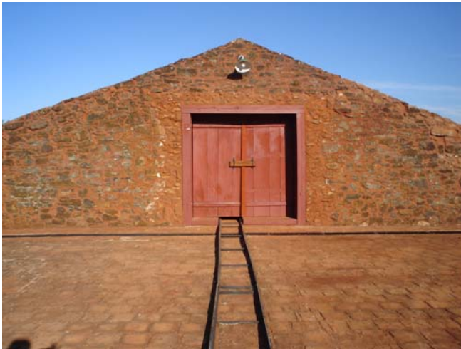
Fig.3.5: Vista frontal da Tulha, edifício do conjunto rural que serviu de motivação para a realização do curso PinhalDigital.
