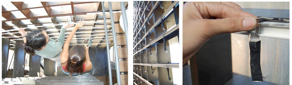
**Fig. 106:** Instalação das canaletas nas quais os suportes dos LEDs foram fixados.
