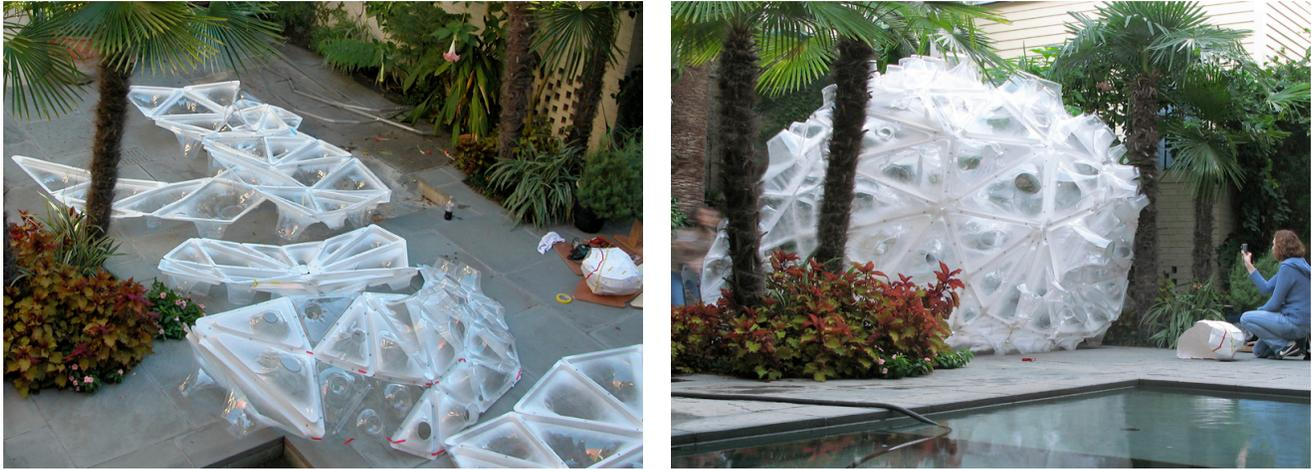
**Figura 15.** Grupos de células e a vista exterior depois da montagem.
