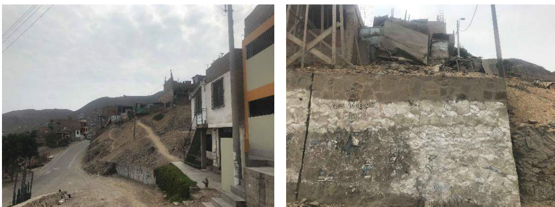
Fig 54. Muros de Contención en la Barriada La Enenada. Fuente: Propia, 2020.
